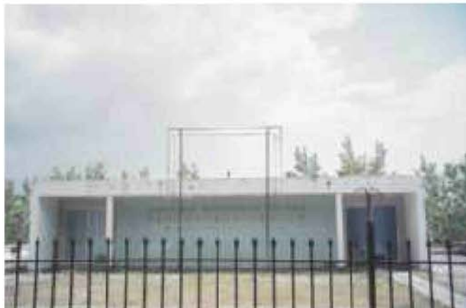
Εικόνα 10 Εξωτερική άποψη του κτιρίου των Λουτρών
